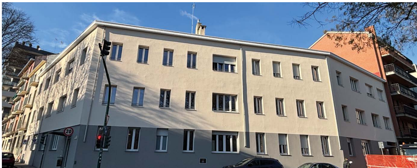
Intervento di ristrutturazione in Piazza Massaua
